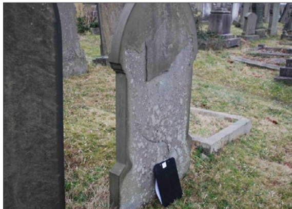
Descamação de um dos lados de uma lápide de arenito (o outro lado não foi afetado). Ecclesall Churchyard, Sheffield
